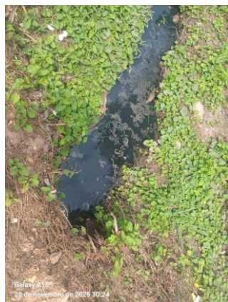
Figura 11 – Ponto de lançamento a céu aberto do conduto do ponto 2.
