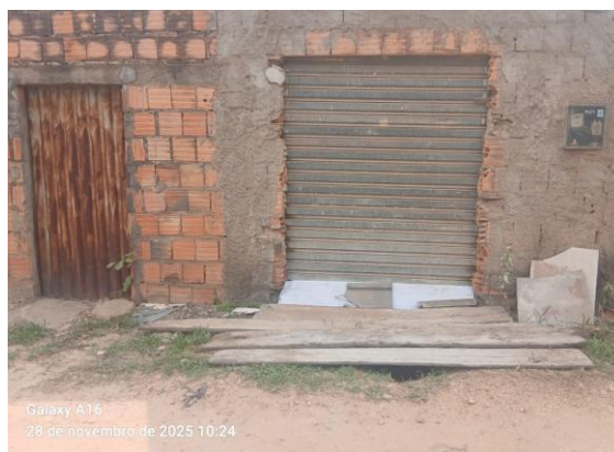
Figura 10 – Ponto de estreitamento do conduto do ponto 2.
