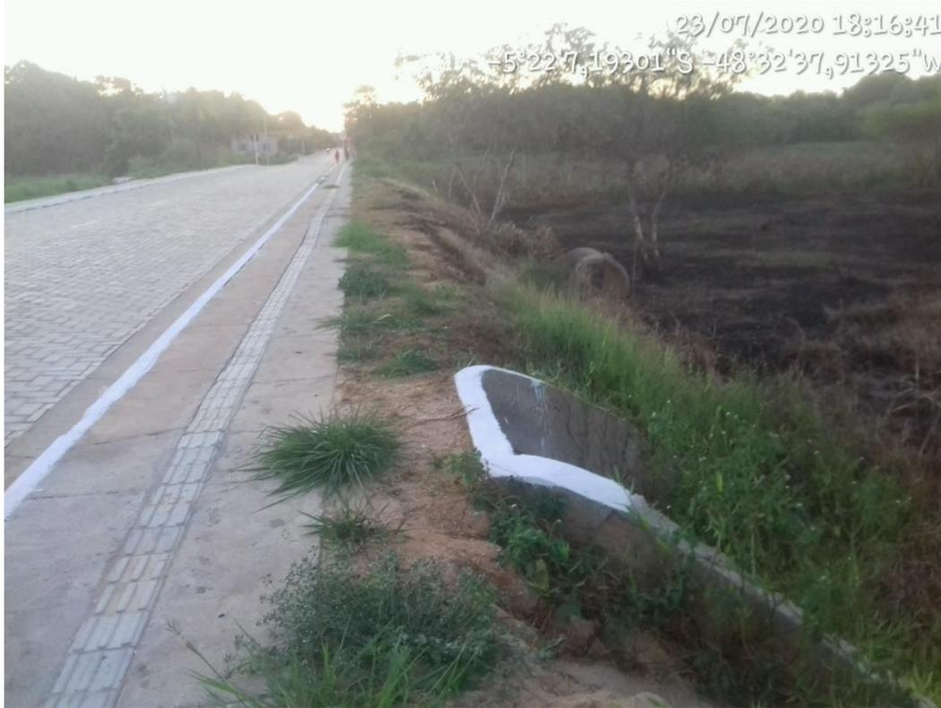
Figura 67: Macro drenagem - Galeria de água pluvial existente no município de Esperantina - TO
