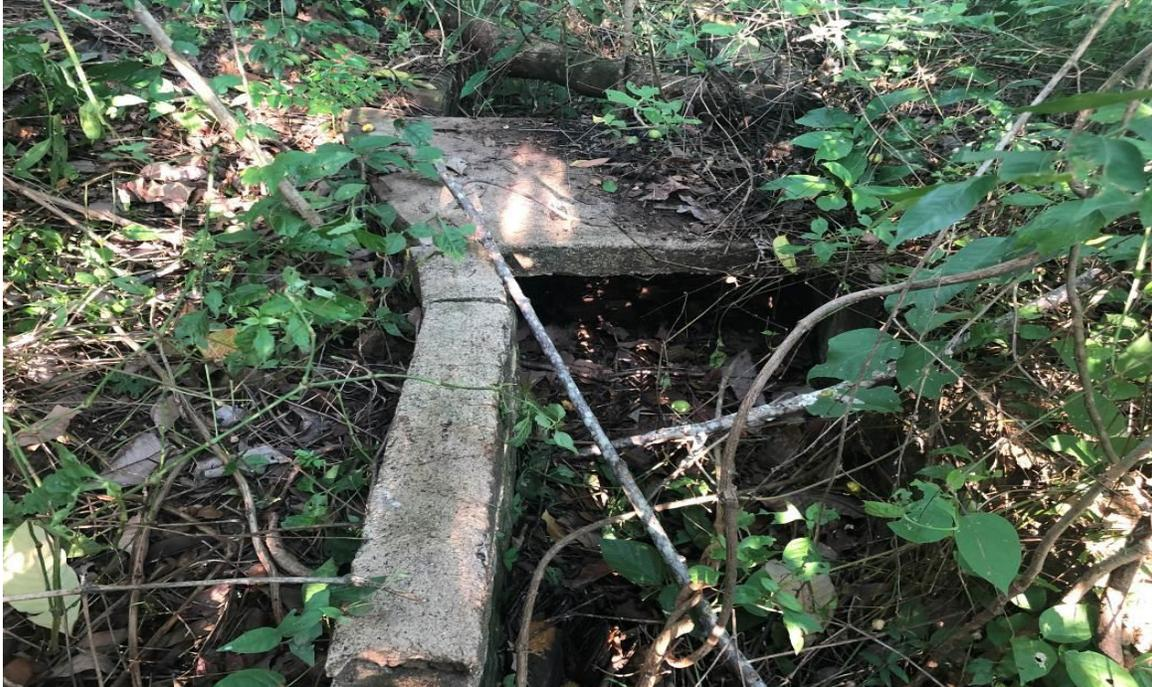
Figura 57: Tratamento preliminar por gradeamento manual em situação de deterioração.
