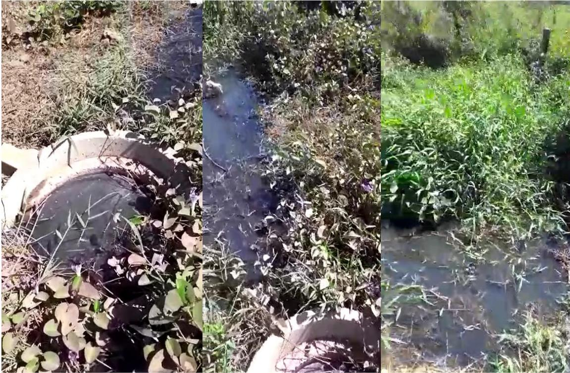
Figura 52: Extravasamento do Poço de Visita da chegada da rede coletora na EEE.
