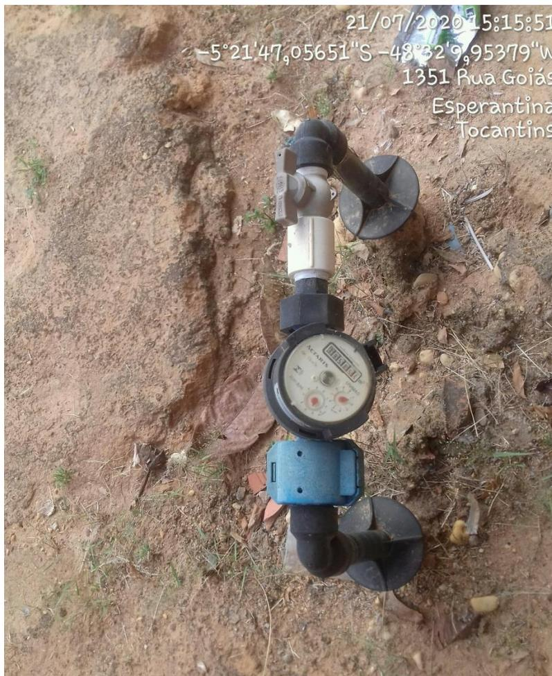
Figura 28: Hidrômetros instalados nas residências e comércios de Esperantina - TO.
