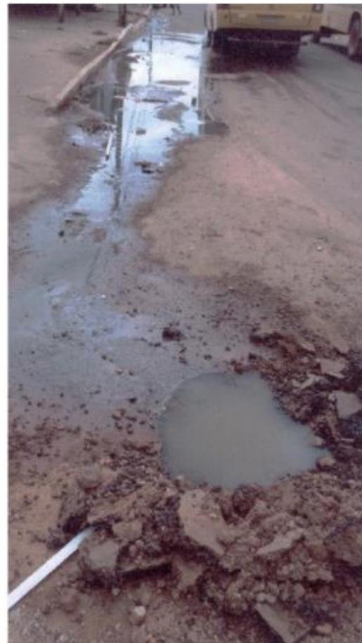
Figura 62: Registro de vazamento de esgoto ocasionado em PV na cidade de Esperantina - TO (MPTO, 2018).
