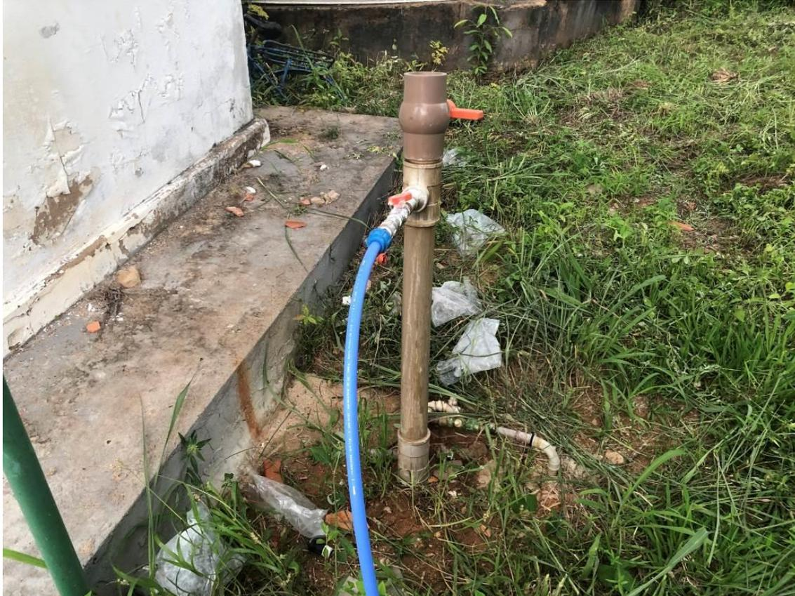
Figura 23: Sistema de simples desinfecção para adicionar o cloro manualmente.
