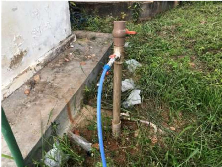
*Figura 3: Sistema de simples desinfecção para adicionar o cloro manualmente.*
