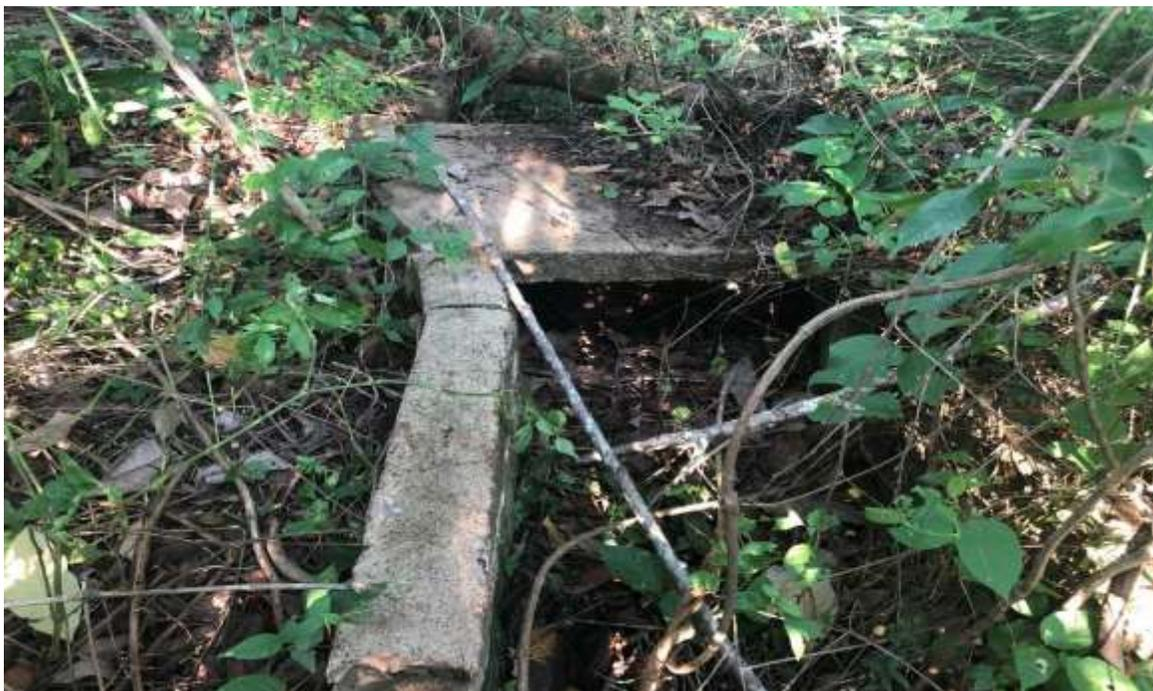
Figura 27: Tratamento preliminar por gradeamento manual em situação de deterioração.
