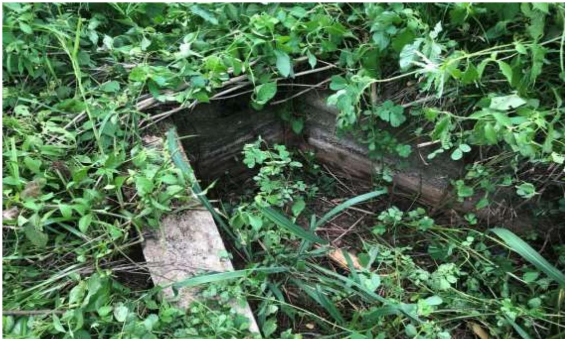
Figura 30: Saída do esgoto "tratado" (entupido) com disposição final no solo.
