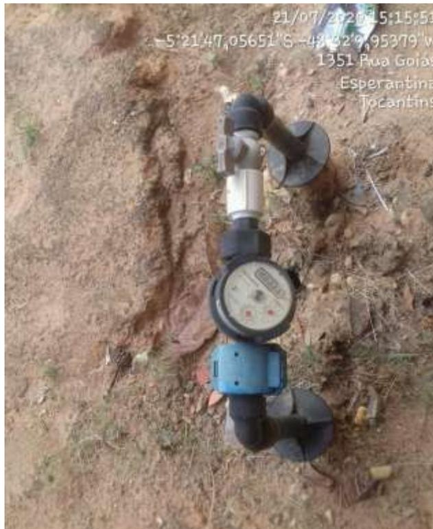
Figura 7: Hidrômetros instalados nas residências e comércios de Esperantina - TO.
