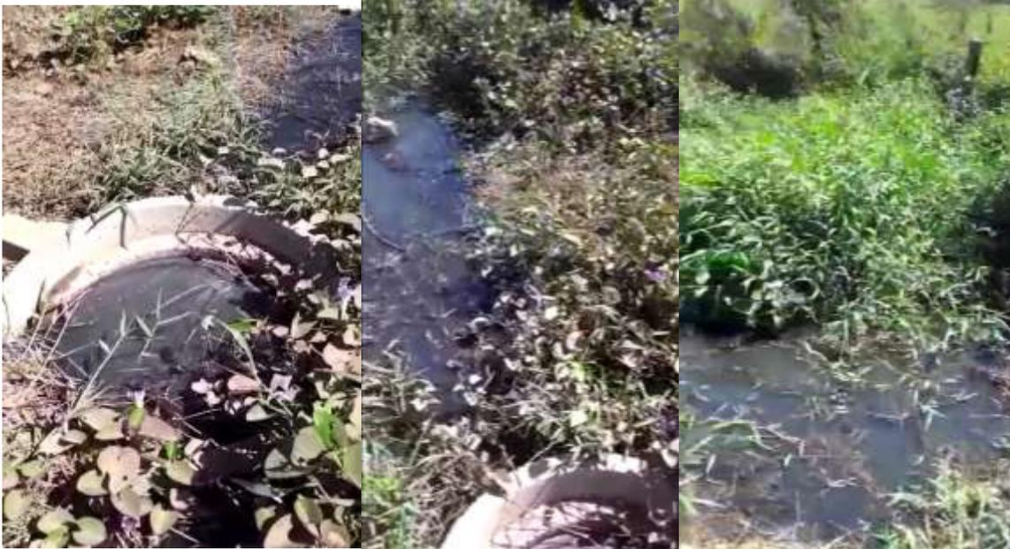
Figura 23: Extravasamento do Poço de Visita da chegada da rede coletora na EEE.
